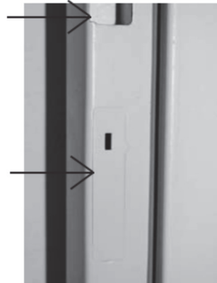
Bild 7: Falle und Riegel freilegen
