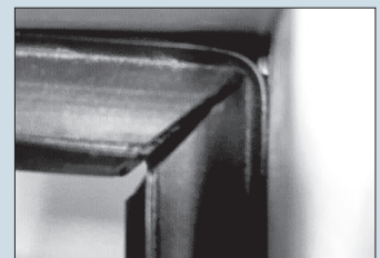
Dichtungsmontage Rahmenstock: falsch ✗
