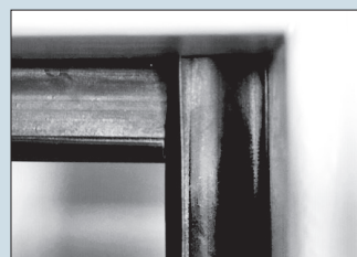
Dichtungsmontage Rahmenstock: falsch ✗
